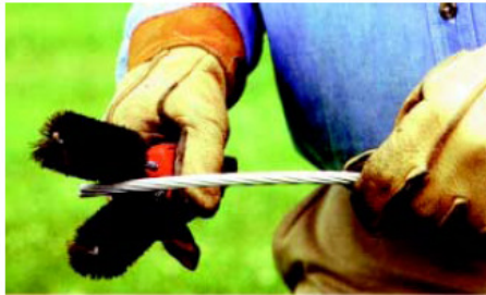
Figura N°2, Limpieza del Conductor
